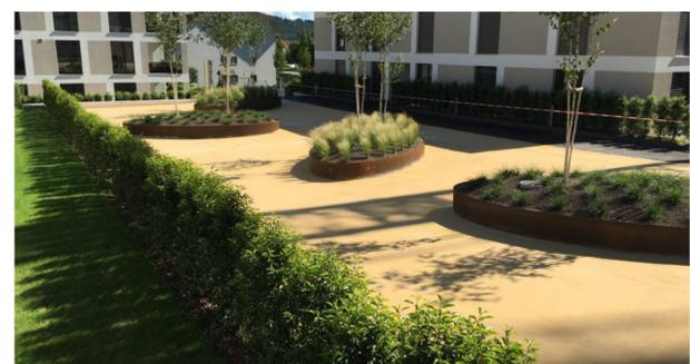
Mit einer wassergebundenen Wegedecke lassen sich geschwungene Formen hervorragend umsetzen. Als weiterer Vorteil ist ein relativ kostengünstiger Einbau und der ökologische Aspekt einer entsiegelten und damit wasserdurchlässigen Flächenbefestigung zu nennen.
