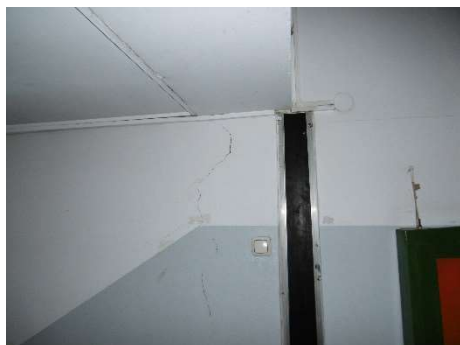
Flurbereiche im Kellergeschoss mit Stahlverstreben zur statischen Unterstützung (alle Verstärkungen weisen keine brandschutztechnische Qualifizierung auf)
