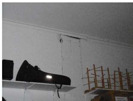
Flurbereiche im Kellergeschoss mit Stahlverstreben zur statischen Unterstützung (alle Verstärkungen weisen keine brandschutztechnische Qualifizierung auf)
