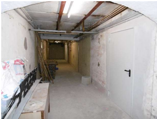
Flurbereiche im Kellergeschoss mit Stahlverstreben zur statischen Unterstützung (alle Verstärkungen weisen keine brandschutztechnische Qualifizierung auf)
