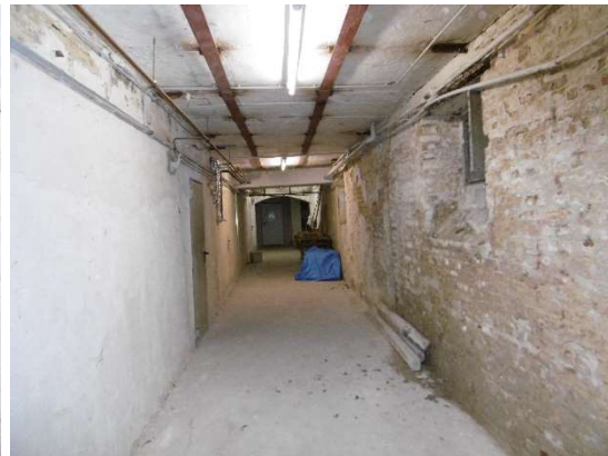
Flurbereiche im Kellergeschoss mit Stahlverstreben zur statischen Unterstützung (alle Verstärkungen weisen keine brandschutztechnische Qualifizierung auf)
